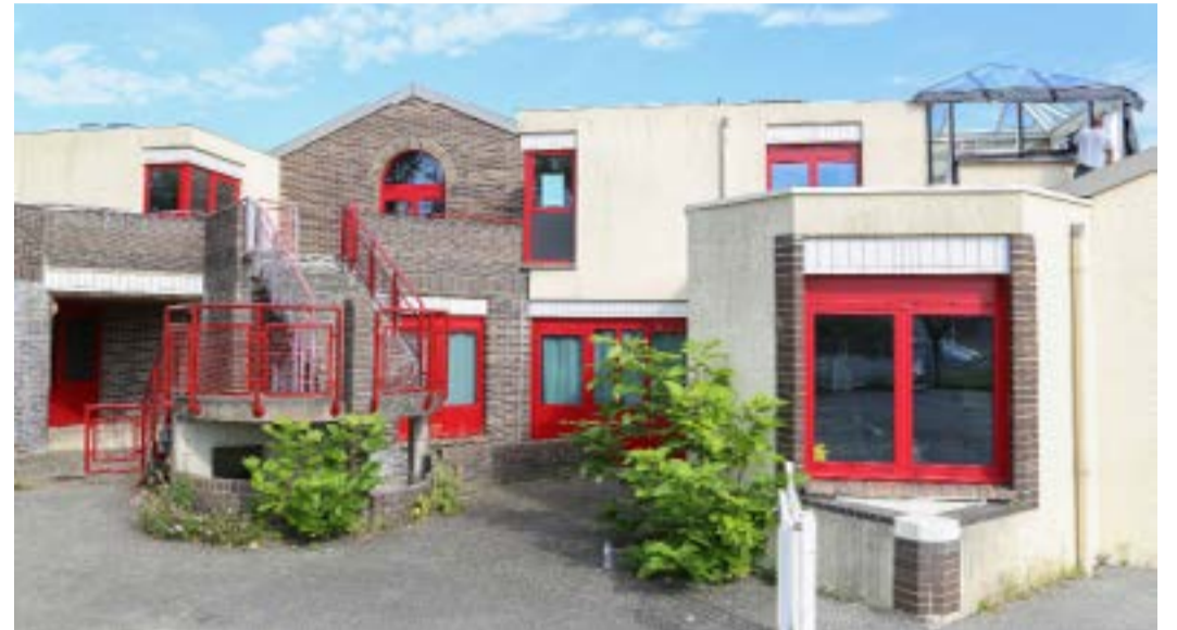
La totalité des menuiseries a été remplacée cet été au groupe scolaire Paul Fort dans le cadre de sa réhabilitation thermique.
