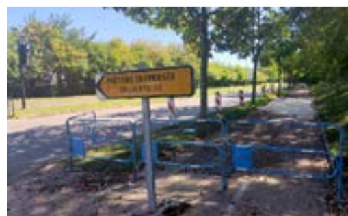
La piste cyclable sud de l'avenue de Kierspe sera réhabilitée et deviendra une voie mixte pour la fin septembre.
