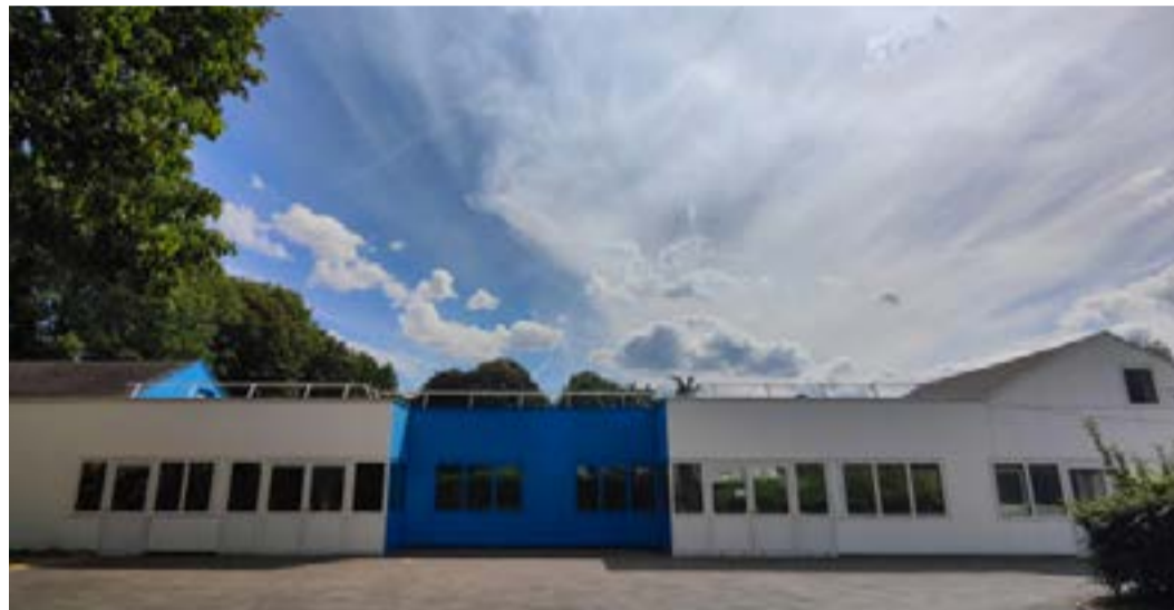
Toujours installée aux Prés pour cette rentrée, la Maison de la réussite aura son entrée propre dans les locaux qu'elle partage désormais avec l'école Les Prés.
