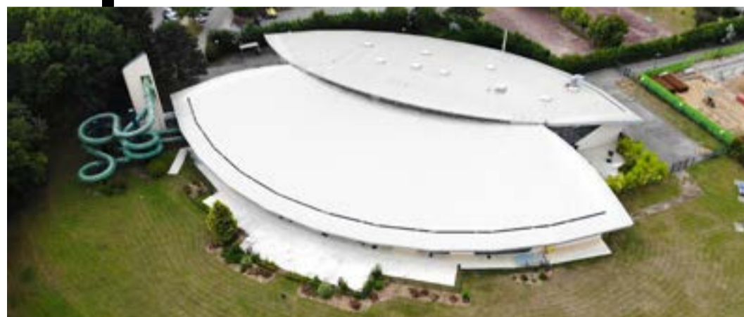
La fermeture du Centre aquatique du Lac le dimanche puis au tout début de l'année a permis de réaliser d'importantes économies à hauteur de 20% pour contenir l'augmentation des coûts de l'énergie.
